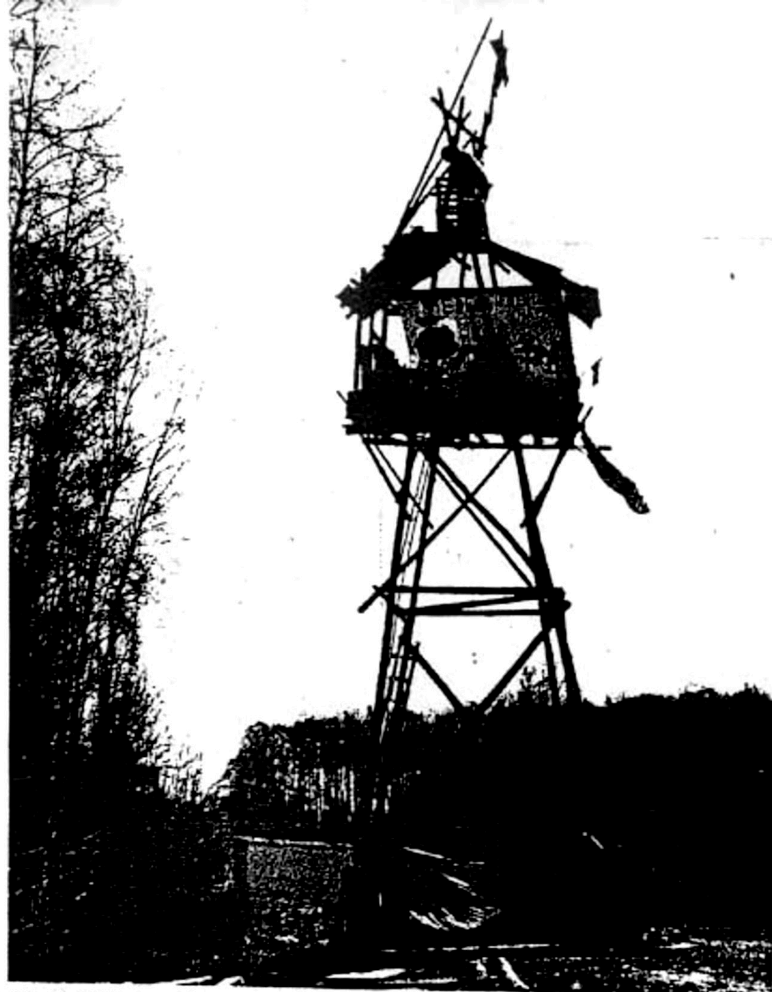
Dieser Wohn- und Aussichtsturm wurde schon vor Ostern auf dem Hüttendorfgelände gebaut. Vorgestern kam ein weiterer Hochbau dazu.
